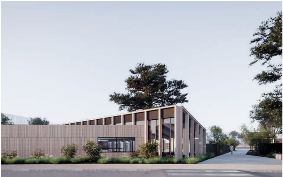
L'école Urbain Le Verrier, en cours de réhabilitation
