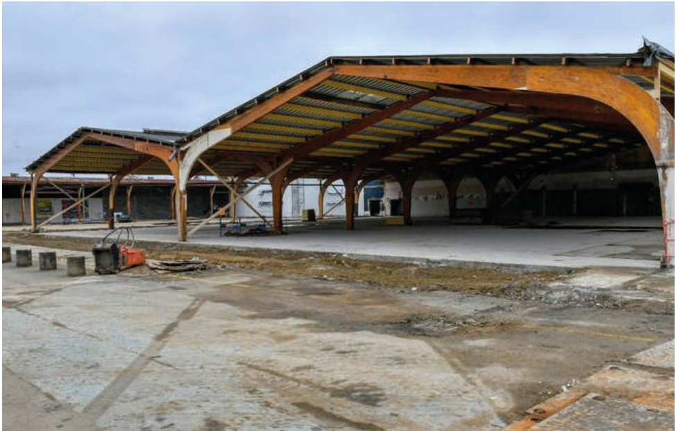
Les halles qui accueilleront bientôt l'épicerie solidaire et le cinéma associatif
