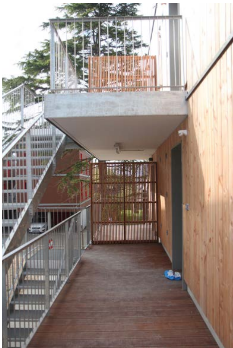
Des coursives extérieures pour des accès individualisés aux logements
