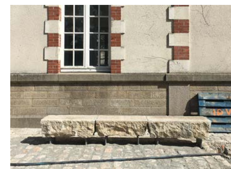
Mobilier urbain à partir de pierres de taille réemployées Photographie Atelier Georges
