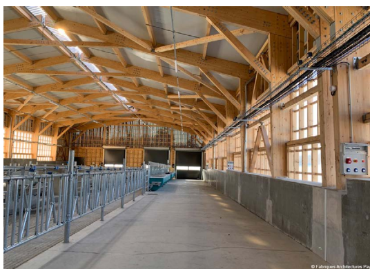
Halle de stabulation expérimentale _ FABRIQUES
