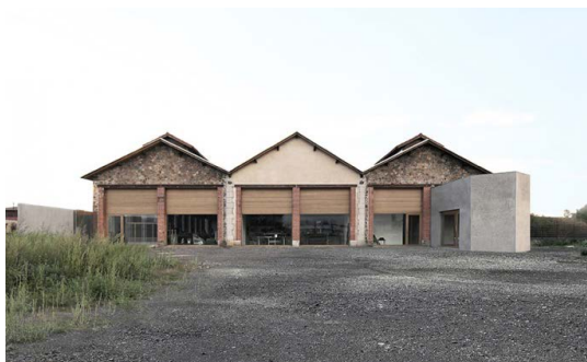
Atelier de verrerie, Brioude - Rénovation par Antoine Dufour
